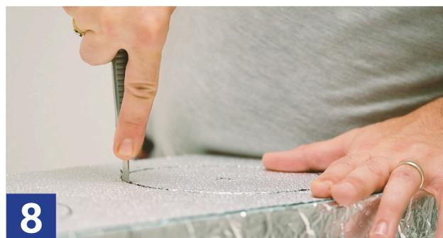
Prendere il secondo pannello, segnare la posizione dei collarini e poi con il cutter fare i fori. **ATTENZIONE:** i nuovi collarini sono realizzati per essere sia maschio per tubo flessibile sia femmina per l'accoppiamento con le serrande motorizzate Opal. Si consiglia di verificare quale delle 2 opzioni è quella corretta prima di forare il pannello.
