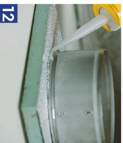
**9** Se serve il by-pass o degli attacchi supplementari per il tubo flessibile, sempre con il cutter, tagliare le pre-tranciate laterali e poi inserire nei fori i collarini. (Collarini speciali non forniti di serie).
